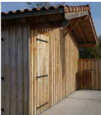
Bardage à recouvrement vertical
