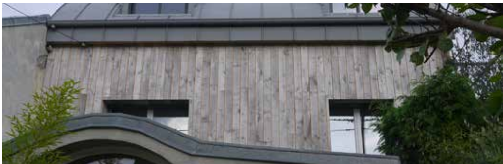
Des transformateurs proposent désormais des produits ayant déjà pris leur teinte grisée. Le bâtiment prend ainsi immédiatement son aspect définitif.
