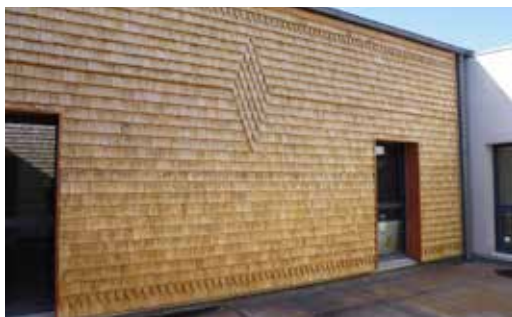
Bardeaux fendus, pose à recouvrement
