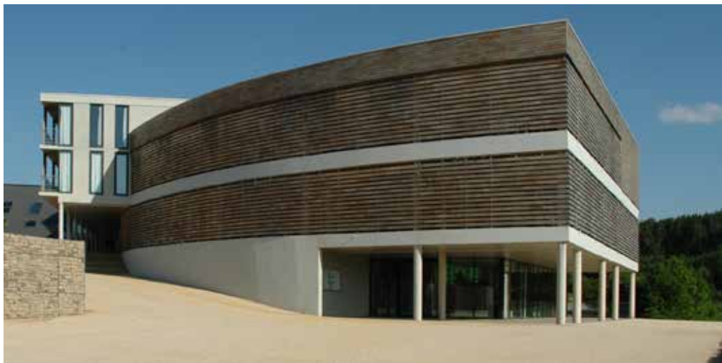
Association esthétique d'une pose horizontale à claire voie et à rainure
