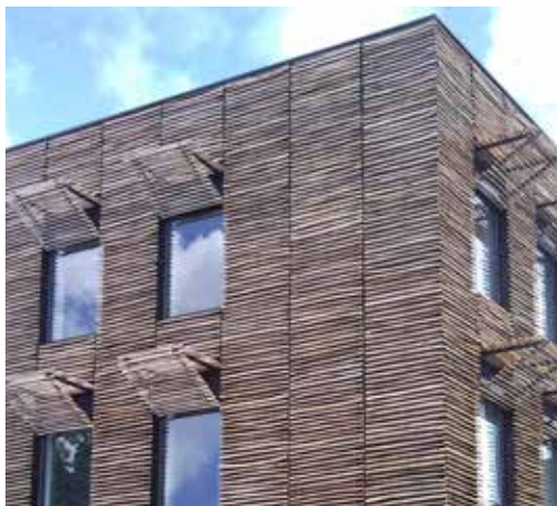
Pose horizontale, petits rondins de châtaignier, d'inspiration ganivelle
