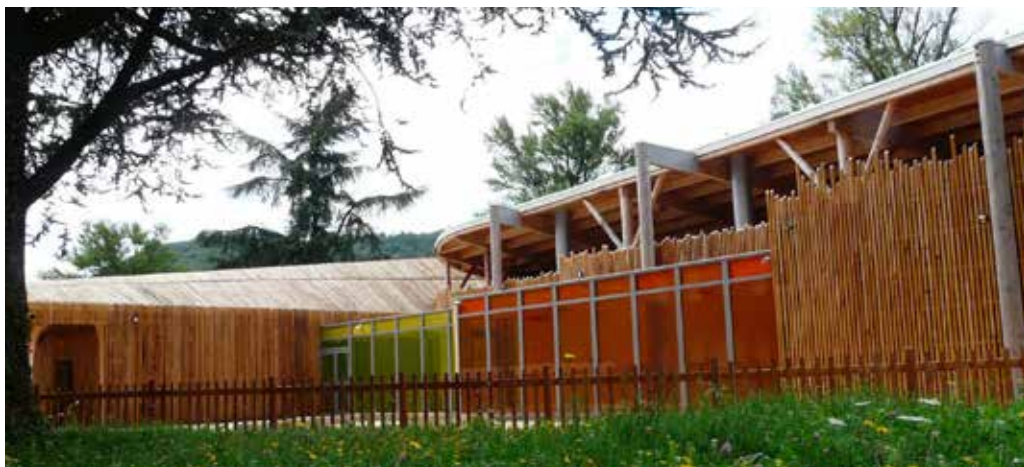
Cité scolaire à énergie positive à Montpezat-sous-Bauzon (07), 100 % du bardage est en châtaignier traité par bioloéthermie aux huiles de lin et de colza. Architecte : Jean-François Daures/VISION®
