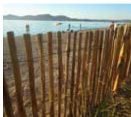
Une protection de l'érosion par le vent
