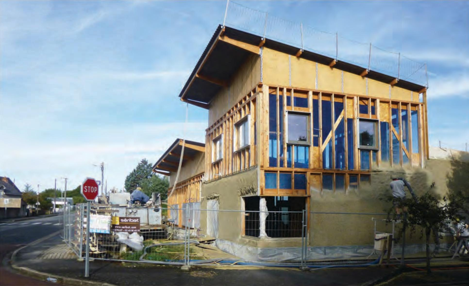
Projection du béton de chanvre qui enrobe entièrement l'ossature
