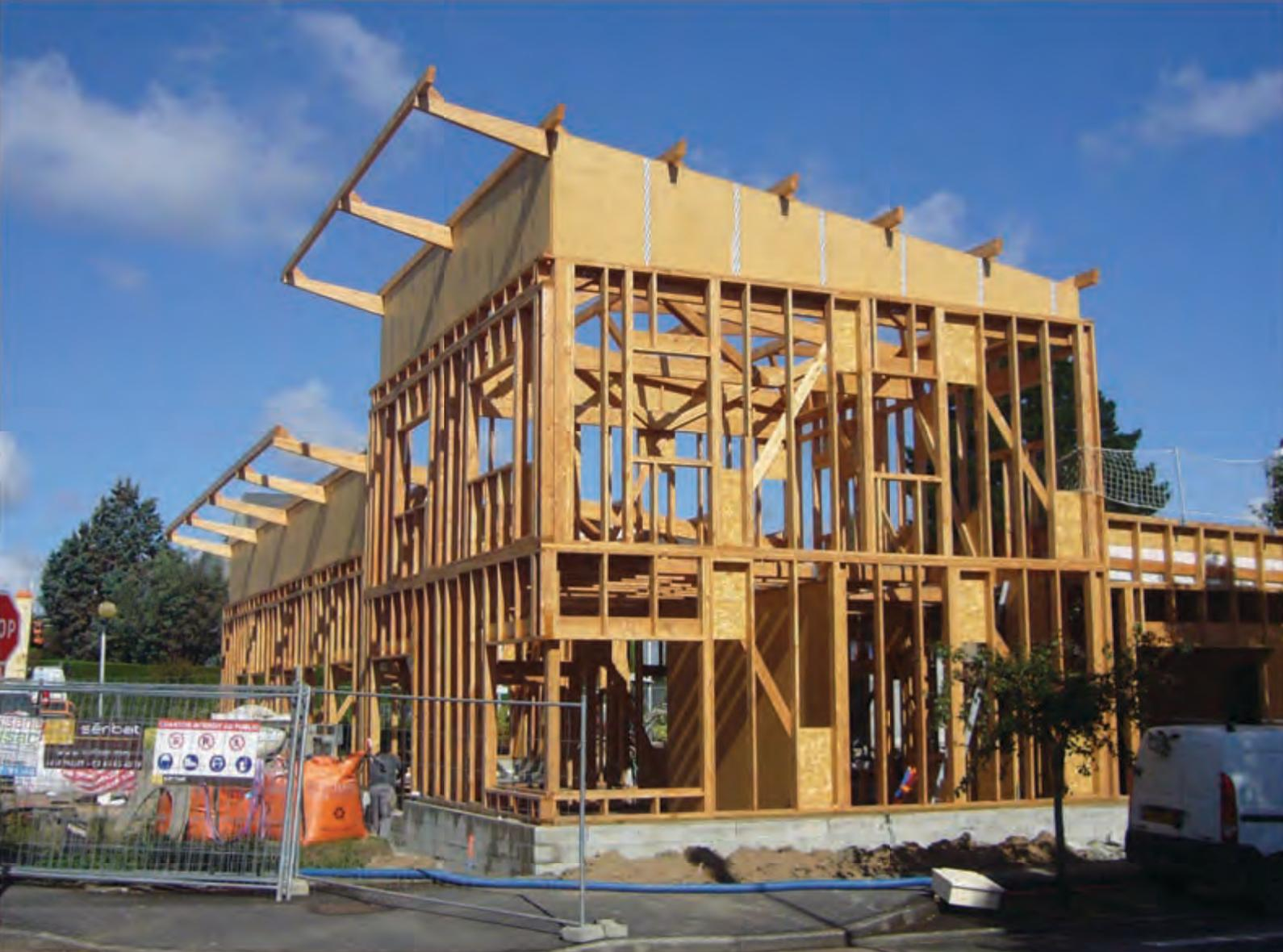
Le contreventement est principalement assuré par des écharpes
